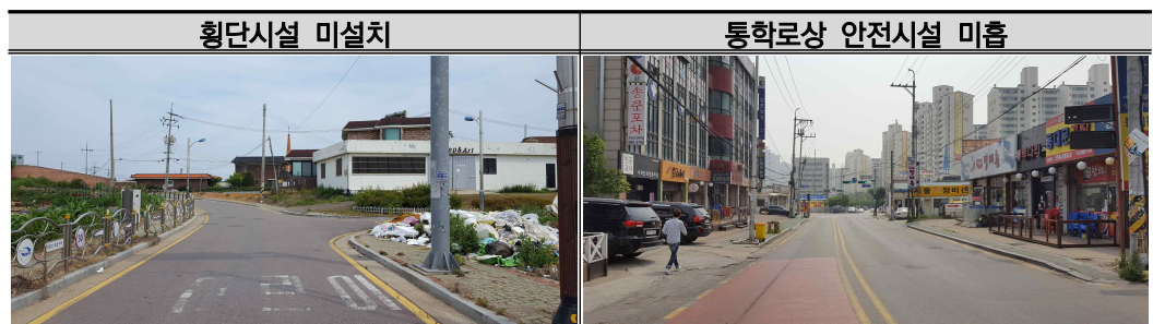
[보호구역 안전시설 미흡 사례]
